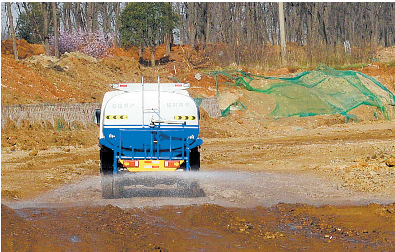
4月7日,一辆洒水车在湛北路西延项目工地开展抑尘作业。为做好大气污染防治工作,该项目施工单位安排洒水车在大型机械作业间隙对工地内部裸露地表开展抑尘作业,努力消除施工扬尘隐患。 本报记者 王尧 摄
