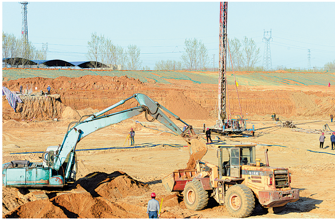
坚守岗位赶进度 4月2日,工人们在湛河治理工程许南路液压坝项目工地修筑深层
