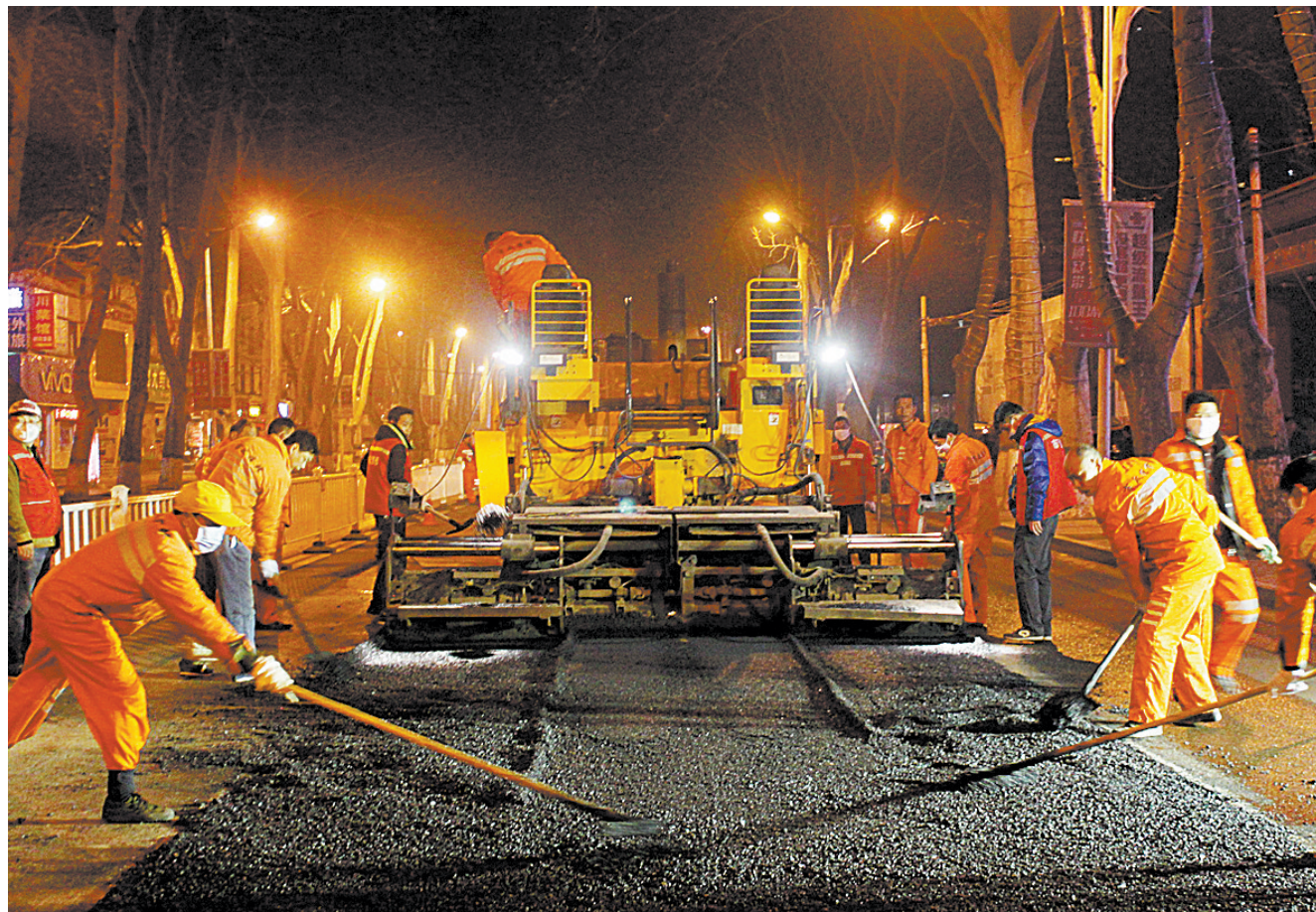
连夜施工保畅通
