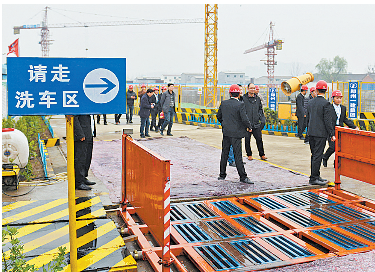
3月29日上午,在新华区新庄村安置点(新庄村棚户区改造)项目施工现场,施工人员在裸露施工地面加盖防尘网。为确保在建设的同时有防尘抑尘,防止施工造成大气污染,该工程从开工伊始就做好防尘抑尘工作,对裸露施工地面加盖防尘网,设立防尘雾炮、车辆冲洗设备。本报记者 牛智广 摄
