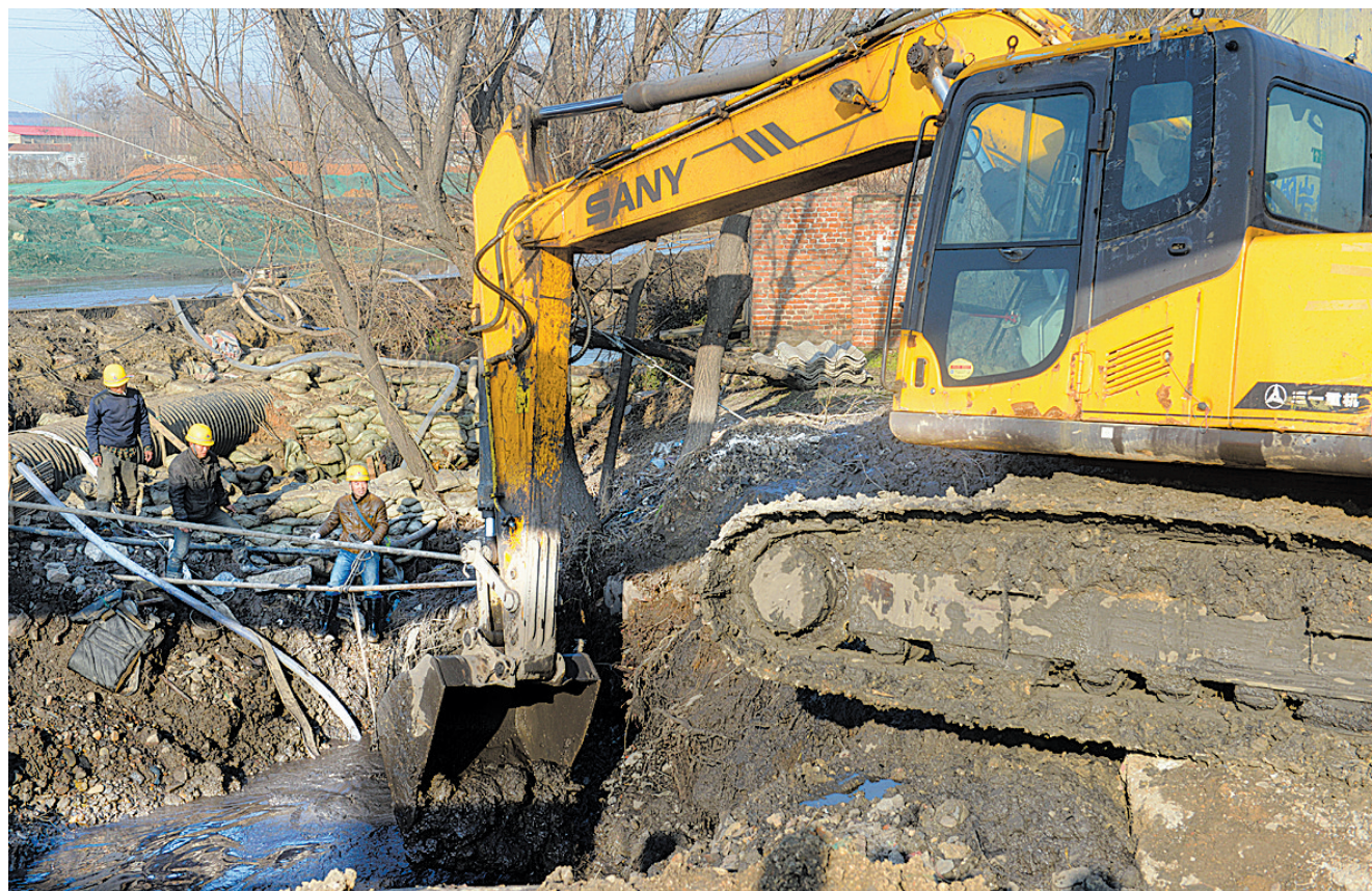
1月8日,工人们配合挖掘机在新庄东沟淇河上游支沟污水导流工程施工现场清理淤泥。 本报记者 王尧 摄
