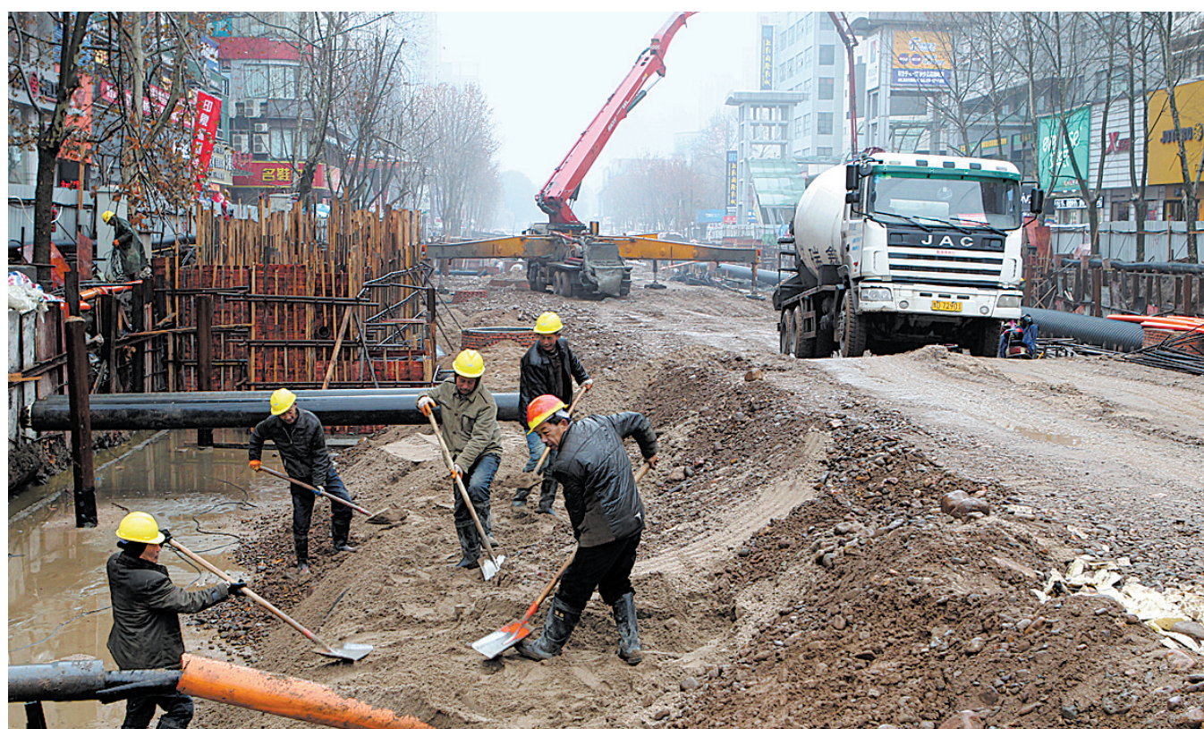
冒雨施工赶进度
