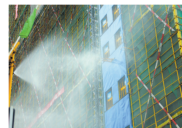
近日,位于迎宾路中段的平顶山宾馆原址改造项目(绿都时代天街)启动喷淋装置。根据我市重污染天气应急预案,该项目施工单位全面停止了所有户外作业,并用防尘网将建筑外表面进行封闭,每隔两个小时开启喷淋装置,对工地围挡内区域开展降尘作业。本报记者 王尧 摄
