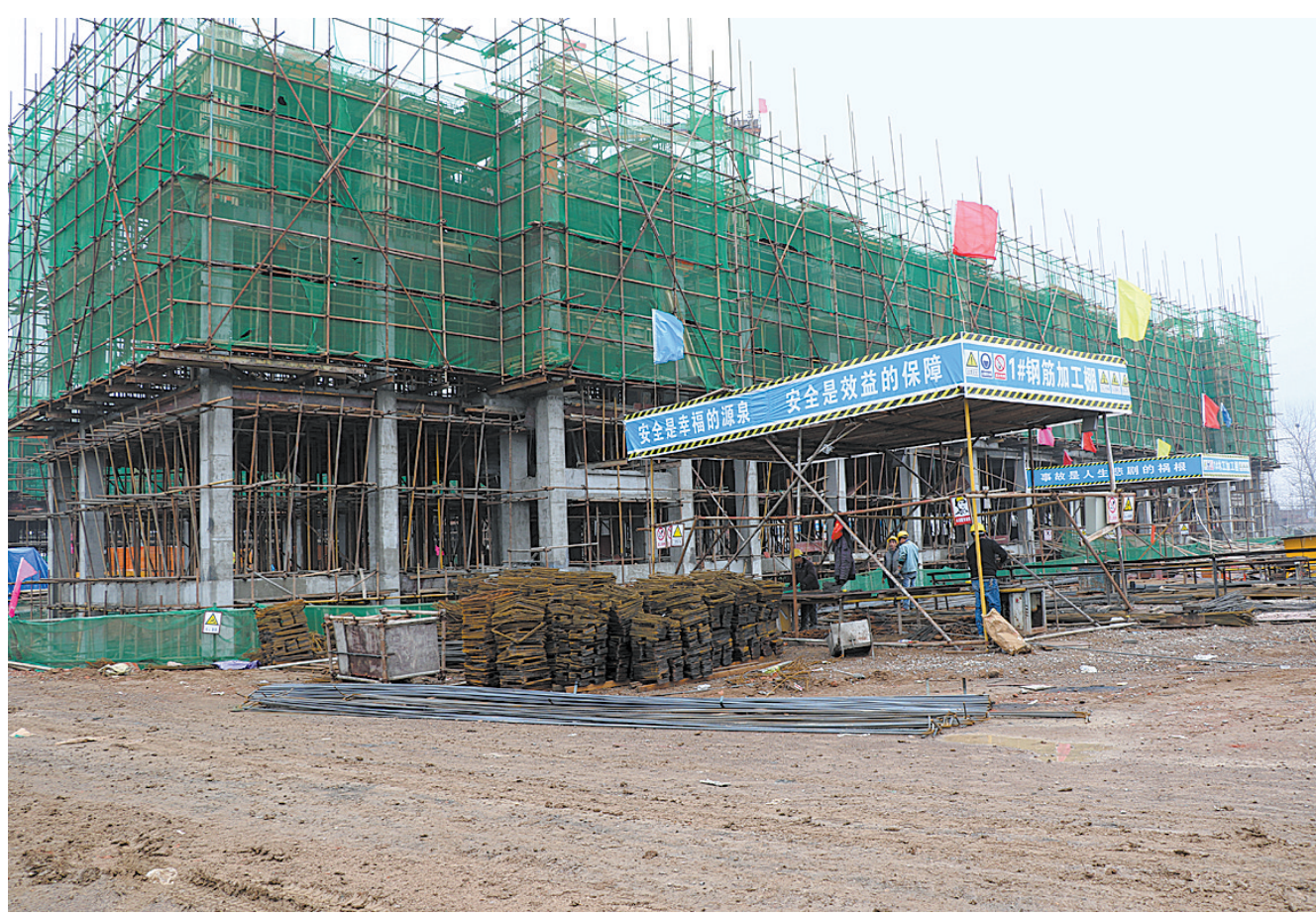
12月21日,郟县第二实验中学(原王集一中)及附属小学新建项目正紧张施工。 为进一步改善办学条件,筹集足够资金,加快项目建设,郟县第二实验中学及附属小学建设资金采取政府和社会资本合作模式(PPP)。该项目总占地160亩,项目总建筑面积37559.35平方米,新建建筑面积33035.96平方米,项目估算投资9987.42万元,包含教学楼、综合楼、学生宿舍、餐厅、教师公寓、多功能厅、运动场等。 项目于今年8月开工,预计明年秋季开学建成并投入使用。项目建成后,将开设60个教学班。 程明豪 摄
