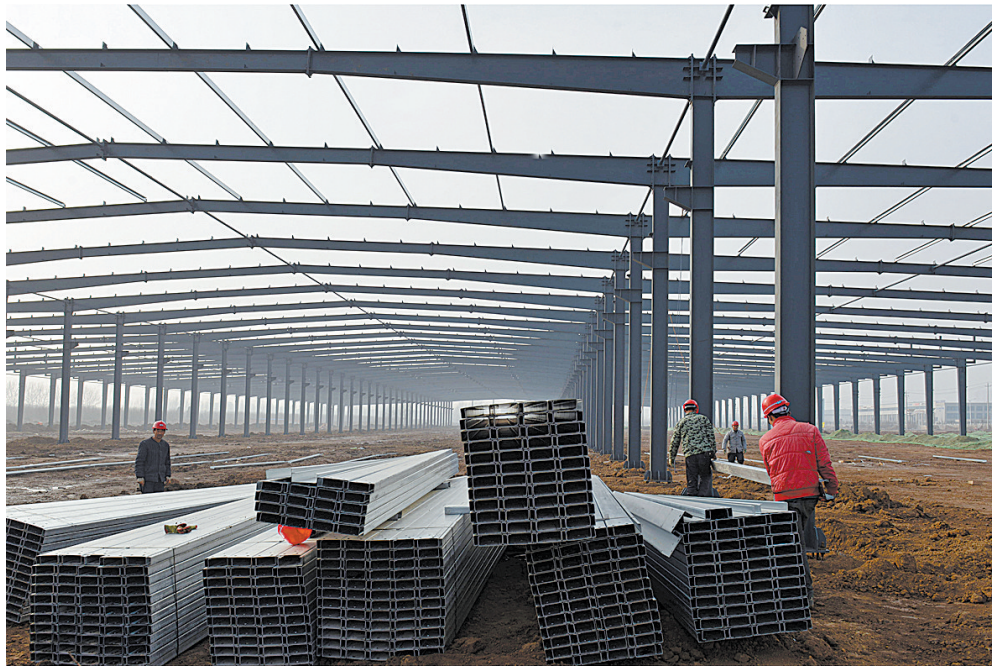
12月23日下午,施工人员在搬运建筑材料。河南钰钰实业有限公司物流产业园项目位于郑县产业集聚区,占地100亩,总投资6亿元,固定资产投资5亿元。该项目包括进口保税仓库、出口监管仓库、集装箱堆场等,并配套建设海关监管办公场所、查验中心、智能卡口、监控设施等。该项目建成后,可进一步促进郑县产业集聚区及周边县区加大对外开放力度。本报记者 牛智广 摄
