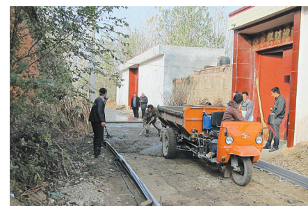
修建排洪道路
