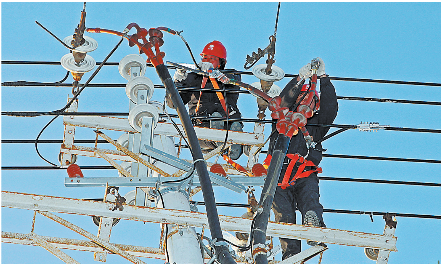
▲国网鲁山县供电公司工作人员深入山区架接电线 本报记者 卢拥军 摄
