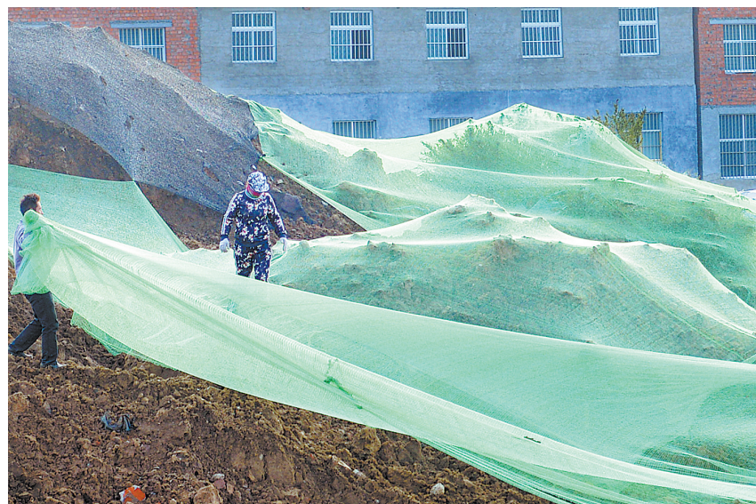
12月19日,工人们在湛河治理国铁桥至许南路标段景观绿化工程施工现场更换一张老化破损的防尘网。
