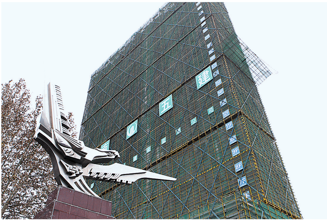
全覆盖施工抑制扬尘
