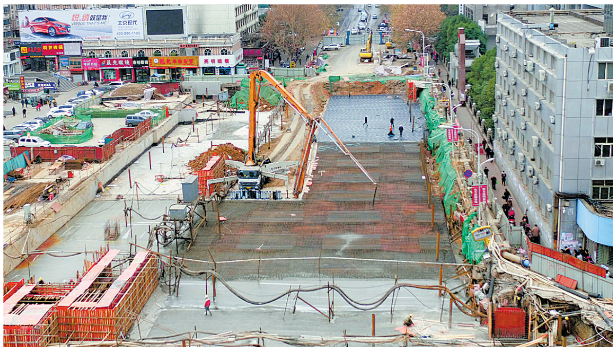
中心广场改造工程开始浇筑混凝土
