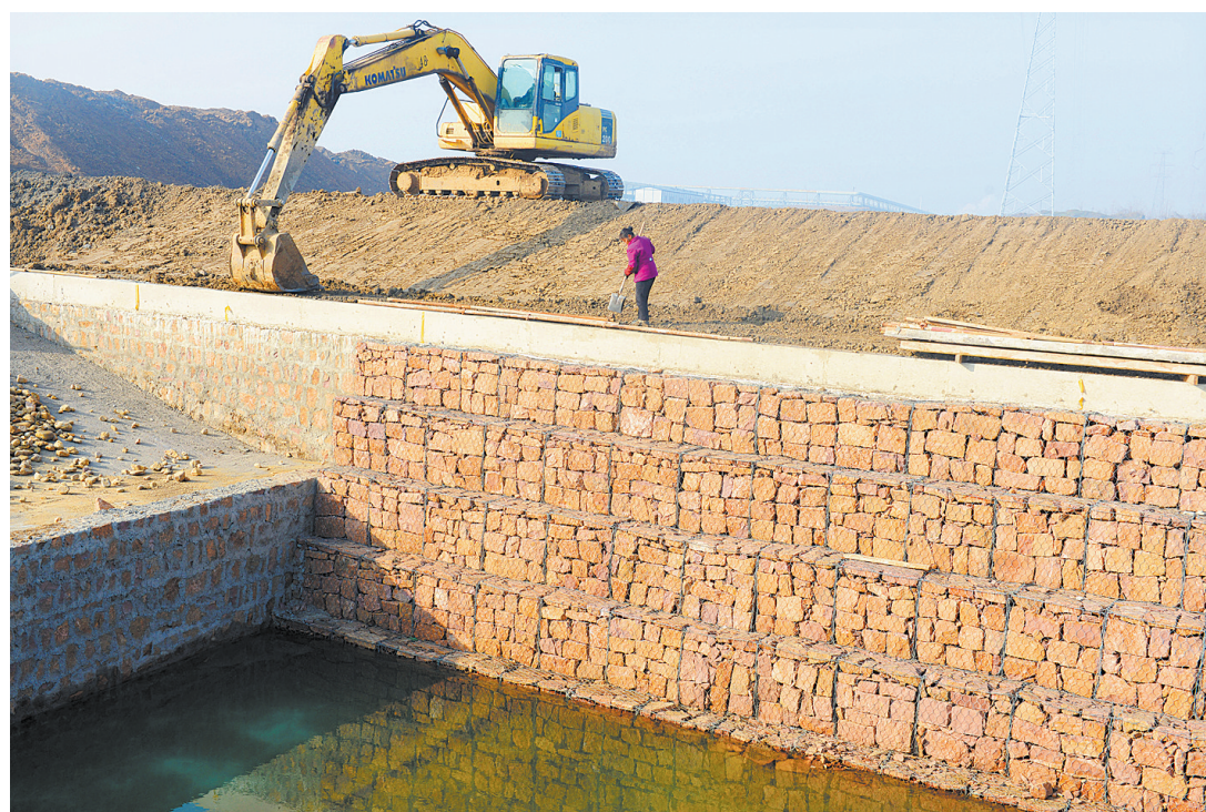
12月9日,施工人员在配合挖掘机在湛河支流张寨沟治理现场回填土方。
