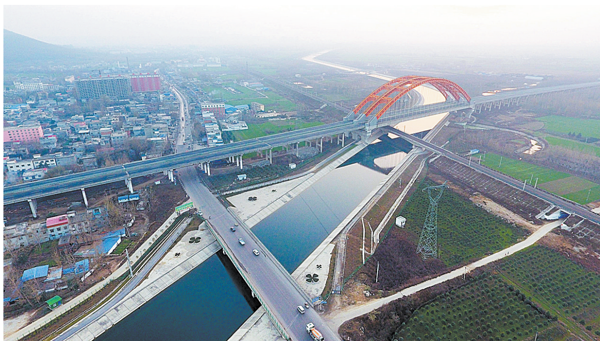
飞阅中国——航拍南水北调中线工程
