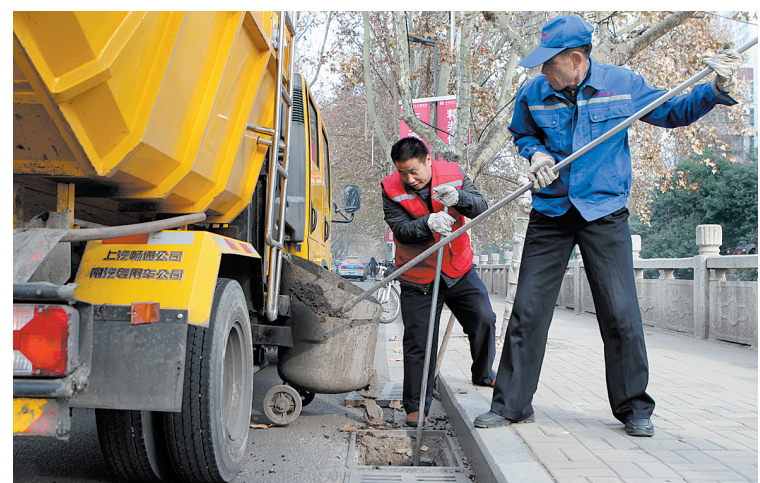
12月5日,市城管处市政维修二队的员工在迎宾路一侧人工清理管井内的淤泥和杂物。入冬以来,大量树枝、落叶随着风雨进入市区
