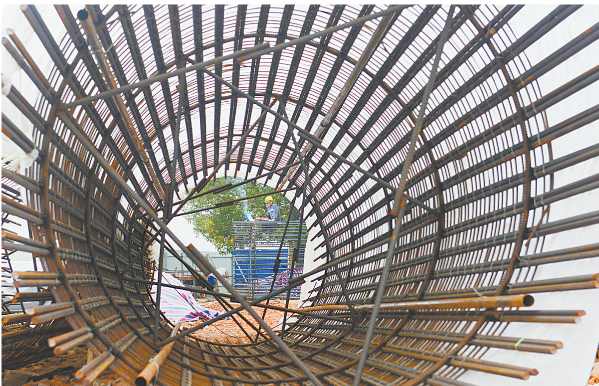
12月1日,工人在工地焊接钢筋笼。姚孟湛河桥位于湛河区姚孟街道姚孟村附近,规划桥面宽25米,其中机动车道宽19米。目前,施工单位正加紧建设。 本报记者 王尧 摄
