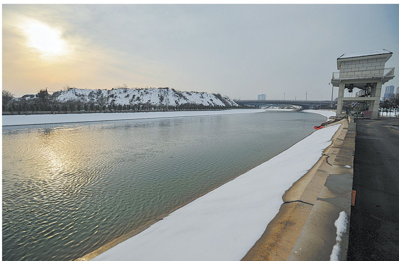
这是11月24日在河南郑州拍摄的南水北调中线郑州段干渠。记者从南水北调中线建管局总调中心获悉,南水北调中线一期工程正式通水
