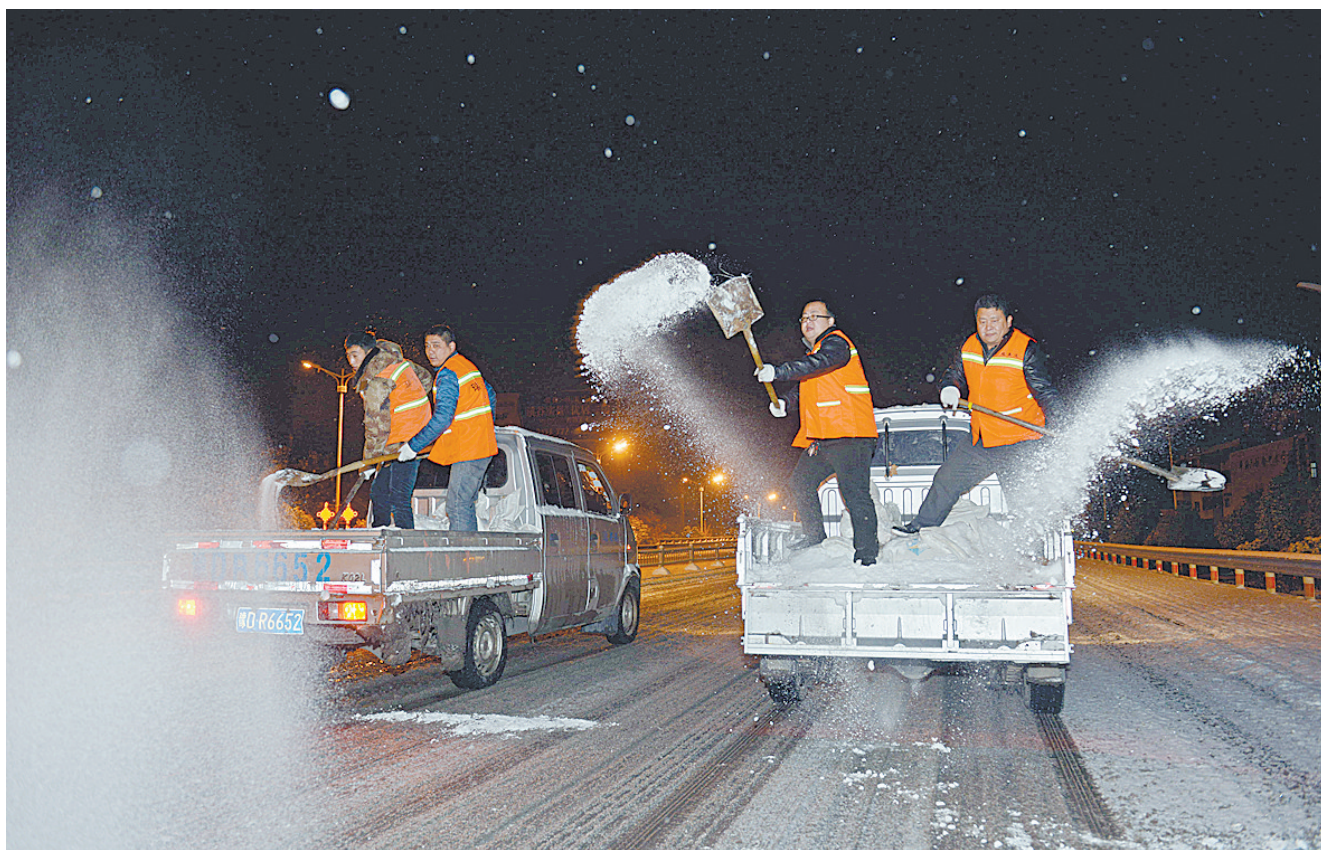
▲11月22日深夜,在市区建设路西段焦店立交桥上,新华区环卫局的环卫职工正在往桥面上撒工业用盐。
