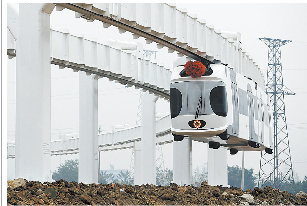
11月21日，在四川成都双流西南航空港经济开发区，一列新能源“空铁”在试验线上运行。当日，由中唐空铁联合
