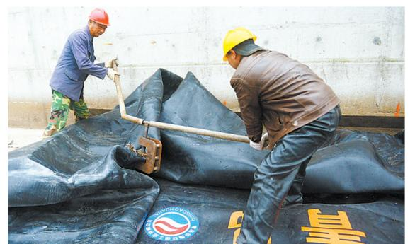
11月20日,工人在湛河治理工程凌洛路至稻田沟段河道治理项目橡胶坝施工现场加紧安装坝头。这座橡胶坝设计坝高3.5米,坝长50米。截至当日,该项目河道内工程已全部完工,施工单位正抓紧推进坝袋安装工作。市湛河治理工作指挥部在橡胶坝坝袋制造阶段选派技术人员赴生产厂家对坝袋生产的五道主要工序进行把关,使坝袋整体质量达到了优良标准。
