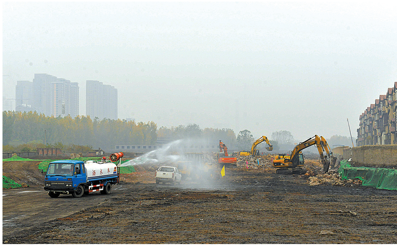
11月18日上午,大型机械在市区南环路西延工程施工现场加紧施工作业,一辆洒水车在对工地裸露土地进行洒水抑尘。
