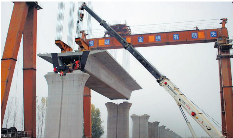
郑万铁路鲁山段架设第一榀箱梁施工现场。
