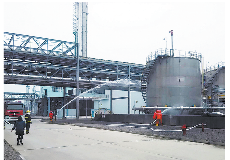
为进一步提高职工的安全意识和应急救援能力,尼龙科技公司组织了苯油漏事故应急救援演练,提高了职工处理突发事件的能力,检验了应急物资备用状态。图为11月9日下午,该公司应急演练现场。王丽娜 摄
