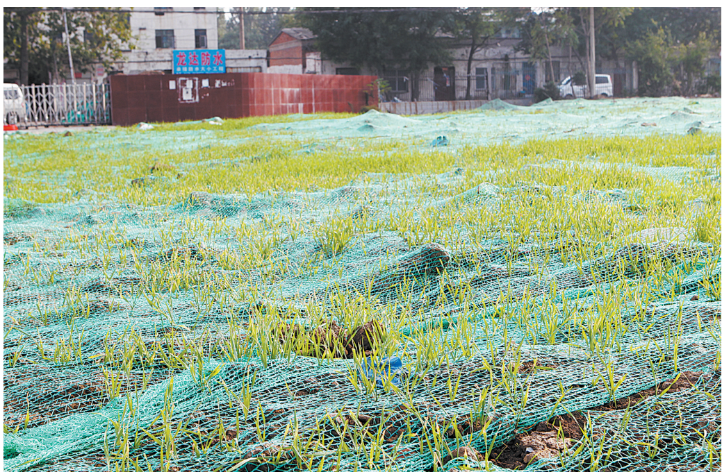
覆盖植绿 抑制扬尘
