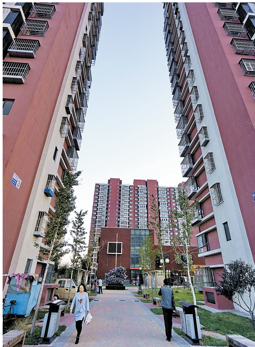
10月8日,居民行走在滨城一期拆迁安置的紫运南里小区。
