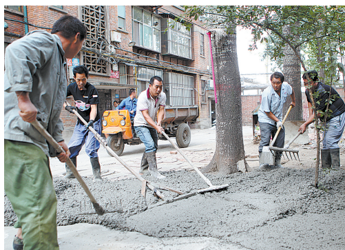
↑9月30日,施工人员在卫东区建设路街道天使社区一个院子内铺设水泥地面。卫东区建设路街道为了做好大气污染防治工作,于本月下旬开始组织施工人员对辖区所有黄土裸露的院落进行硬化,避免风扬起尘。本报记者 姜涛 摄
