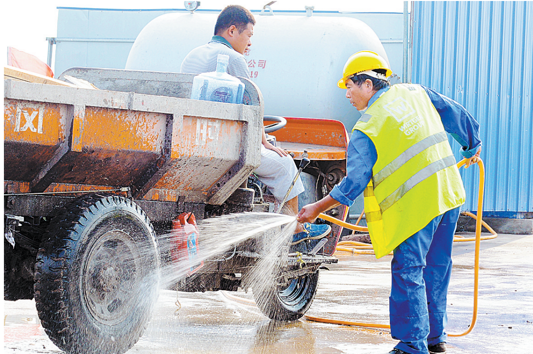
冲洗进出车辆 防治工地扬尘
