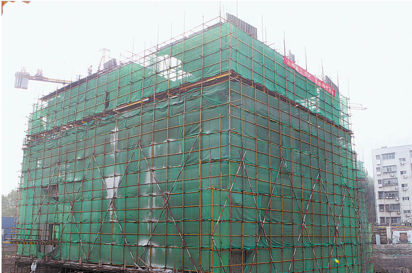
全覆盖施工抑制扬尘
