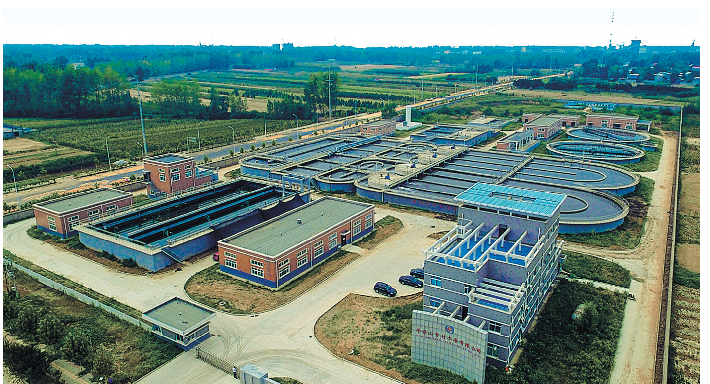
采用工厂模式已经投用的平顶山化工产业集聚区污水处理项目
