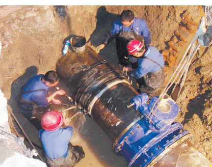
维修人员抢修供水主管道
