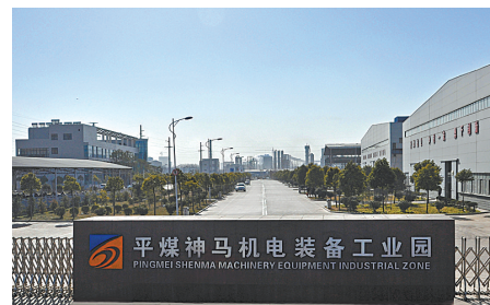
四大产业园之一——机电装备工业园
