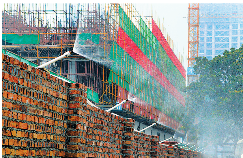
工地安装喷淋设施除尘
