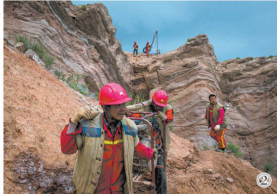
①川庆物探的钻井操作手将数十斤重的钻机架背上山(9月3日摄)。 ②川庆物探的工人将钻机分解后从悬崖上用绳索坠下继续抬往下一处井口(8月29日摄)。 ③川庆物探的钻井操作手易世明在工地吃中饭(8月29日摄)。(均由新华社发)
