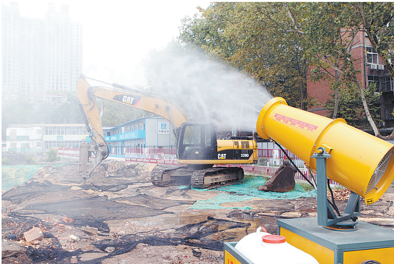
移动喷淋抑制扬尘
