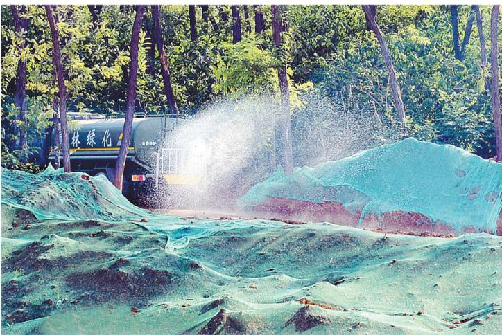
▲8月28日,洒水车在湛南暗涵至稻田沟倒虹吸段工地洒水,施工单位在做好场地覆盖的同时,安排洒水车定时洒水,努力消除施工扬尘。 本报记者 王尧 摄
