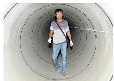
8月21日,市渣河治理工程指挥部工作人员在湛北排污干管内检查施工质量。当天,有4处总长1796.5米的排污工程通过了验收。
