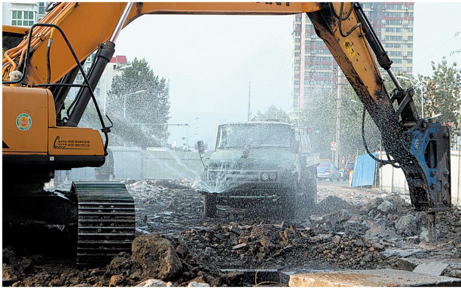
8月21日,记者在孟平铁路复线新华路立交桥桥下引线施工现场看到,施工人员一边利用大型机械破除路面,一边现场洒水抑制扬尘。
