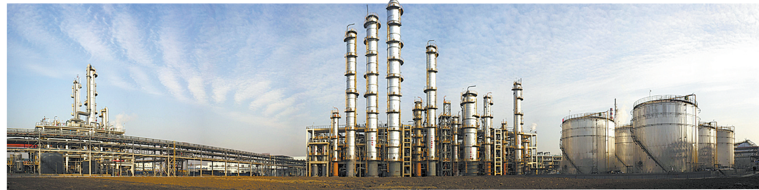
尼龙科技公司厂区一角
