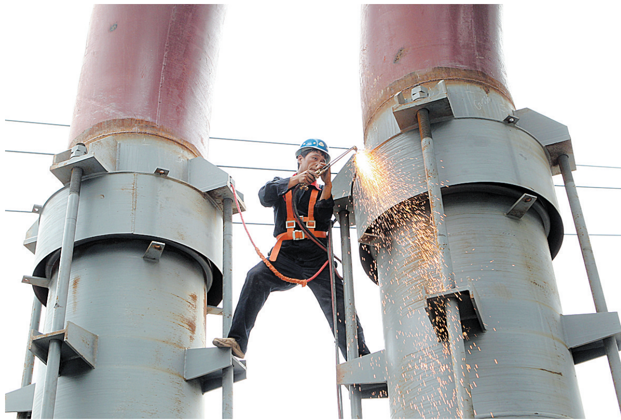
重点工程施工忙
