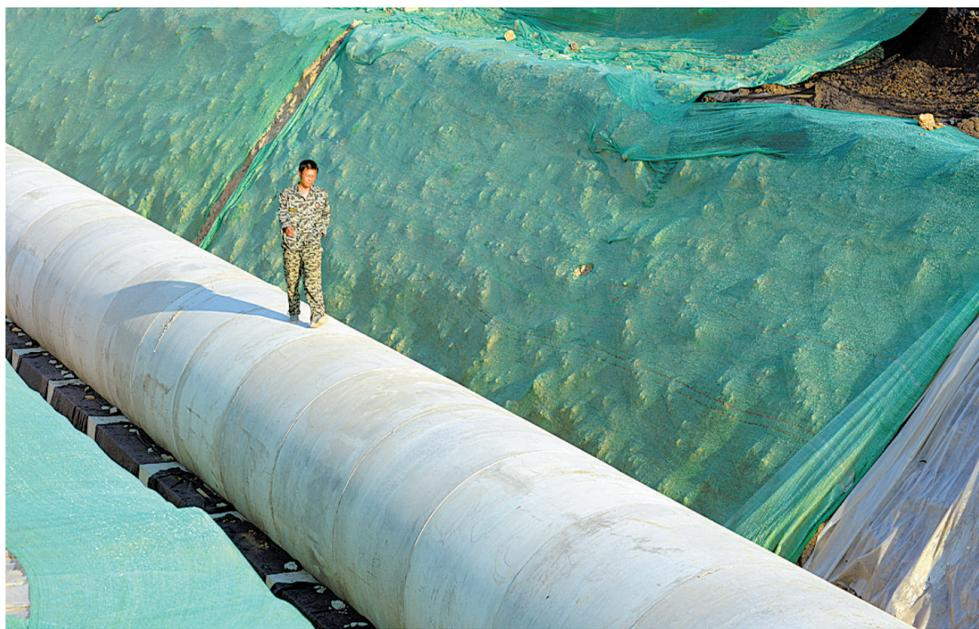
8月15日,一位工人在位于市区凌云路西侧的湛南路西延湛南路施工现场检查管道接缝外观质量。
