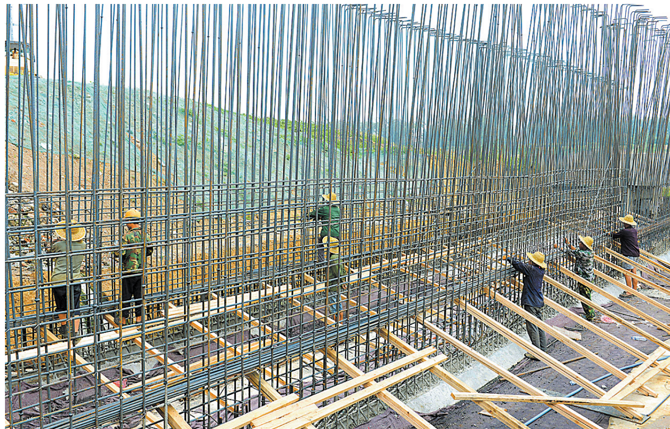
7月6日,工人们在温集沟治理工程施工现场固定钢筋。
