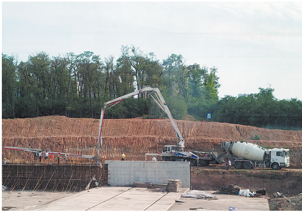
李苗路橡胶坝加紧施工
