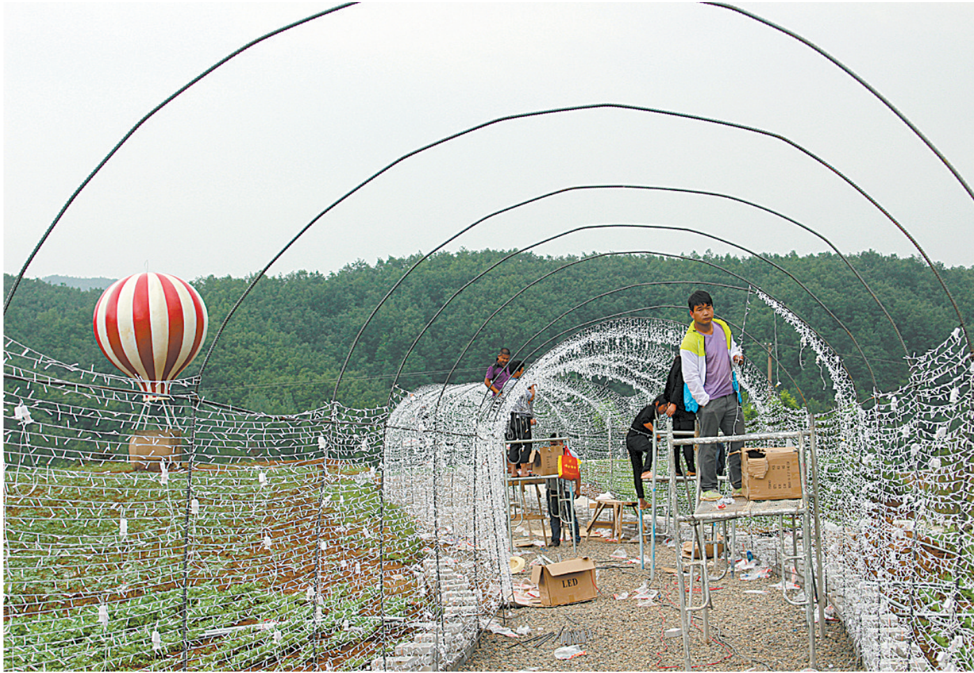
6月7日,尧山镇贾店村几名村民在精准扶贫项目“尧山花海”搭建“灯光隧道”。该项目流转土地800余亩种植金盏菊、马鞭草等20多种花卉,并全部铺设了地理管道。目前,道路硬化、特色山门、高空可视步道等工程已基本竣工。
