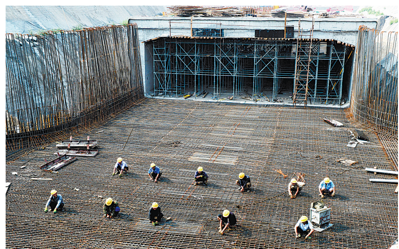
郑州加大城市地下综合管廊建设
