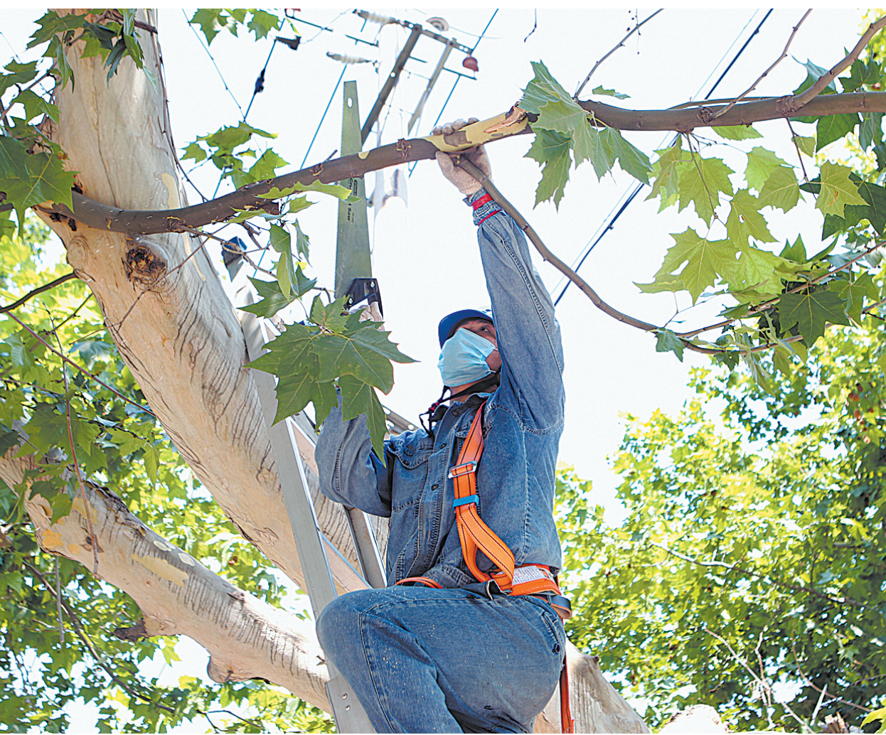
维护线路保供电
