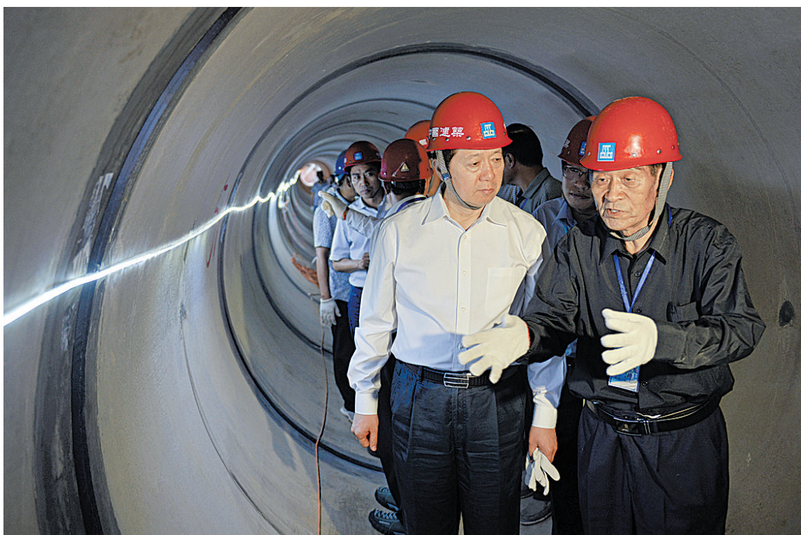
6月8日下午,市委书记郭瑞民(左)和技术人员一起来到湛河综合治理工程湛南顶管工地,下到约6米深的井内,仔细检查顶管工程质量。 本报记者 牛智广 摄
