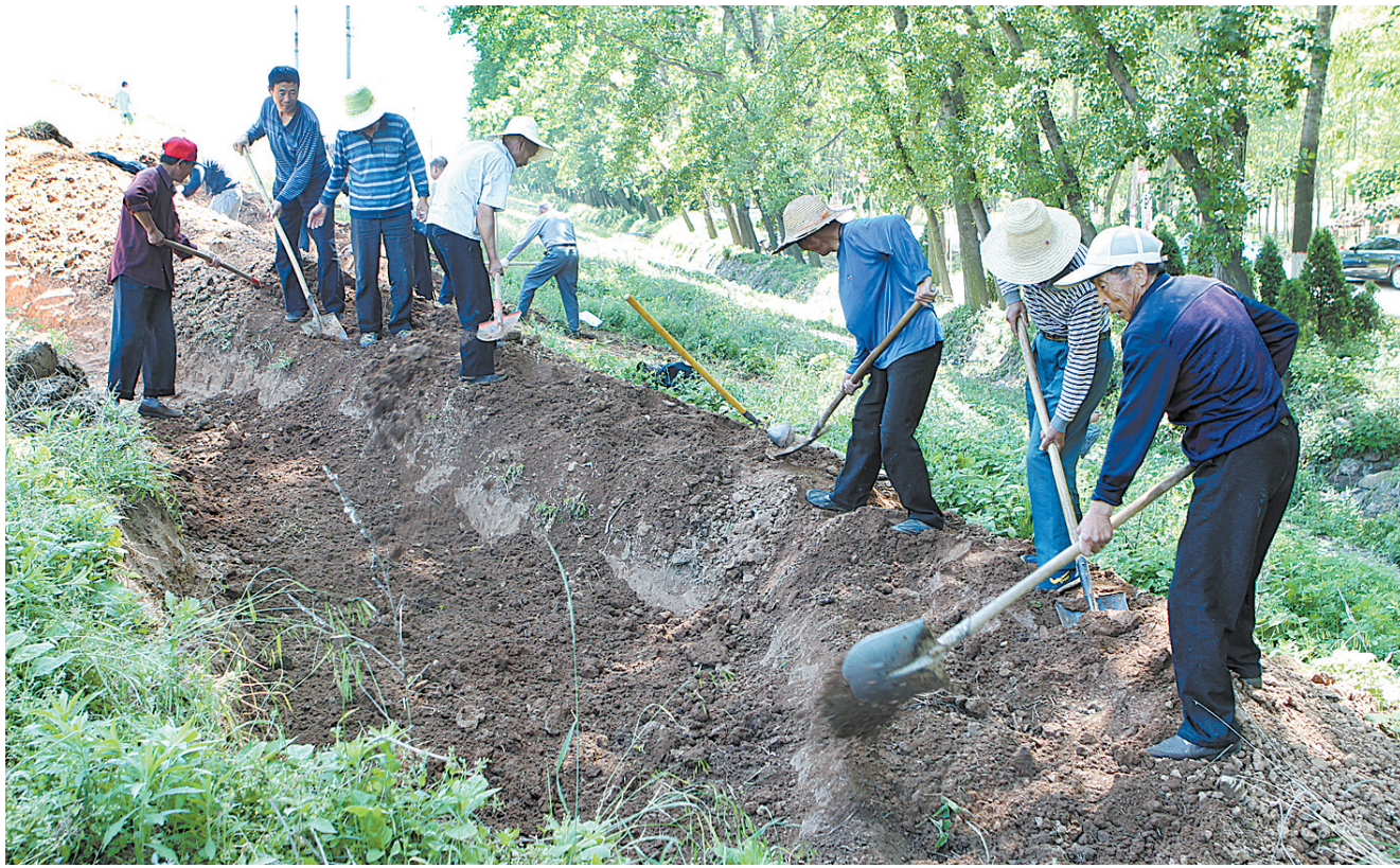
5月16日,施工人员在回填已经清理过的白蚁巢穴。确保大堤安全,白龟山水库管理局于4月下旬开始组织专业人员利用先进的LTD探地雷达在部分堤段精确寻找蚁穴,并在汛期到来之前及时组织施工人员挖渠治理。 本报记者 姜涛 摄
