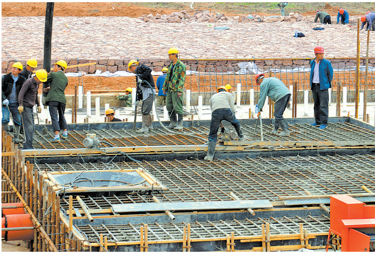
加快推进淇河治理工程
